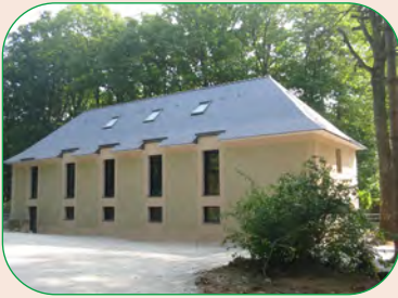
Le bâtiment « Naïm » (dortoir du Foyer Saint-Thomas) achevé.
